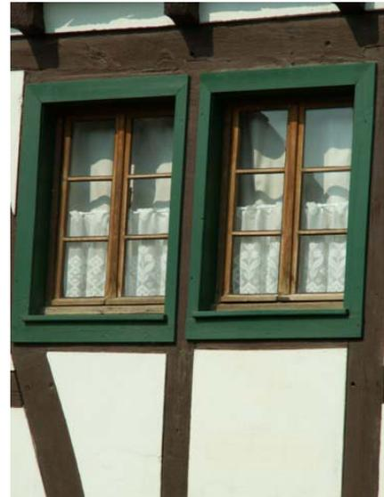
**Bild 40** ... v.a. die Fenster wurde dem Original entsprechend hergestellt
