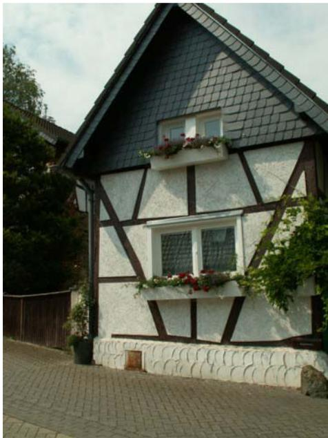
**Bild 35** Historisches Fachwerkgebäude (1753) in der Feldstraße: Fenster und Fassadenverkleidung in Material und Gestaltung mangelhaft
