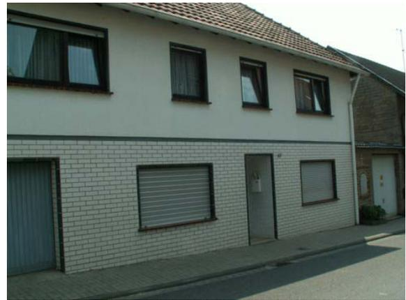
**Bild 54** Häufige Gestaltungsmängel: Klinkerfassade im Sockel oder ganzes EG, Überdimensionierte Fenster (Hauptstr.)
